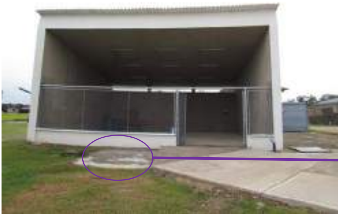
Área de almacenamiento temporal de residuos peligrosos
