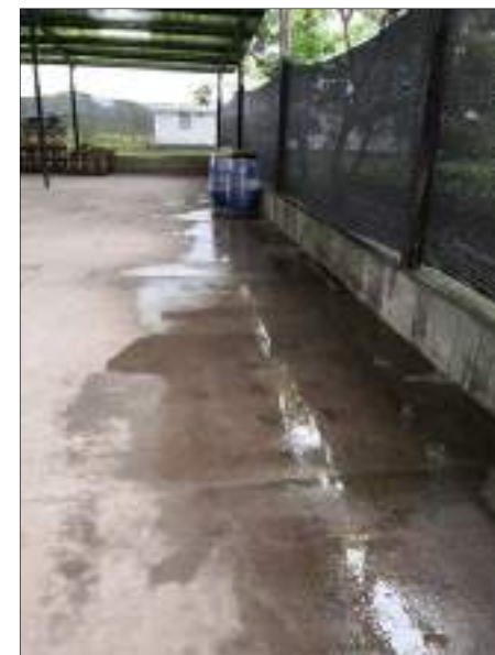
Bodega de almacenamiento de producto formulado. San José de Guaviare, Guaviare.
